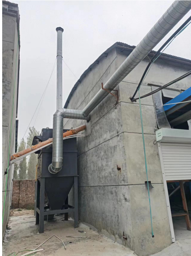
图 3-2 上料、破碎、筛分布袋除尘器
