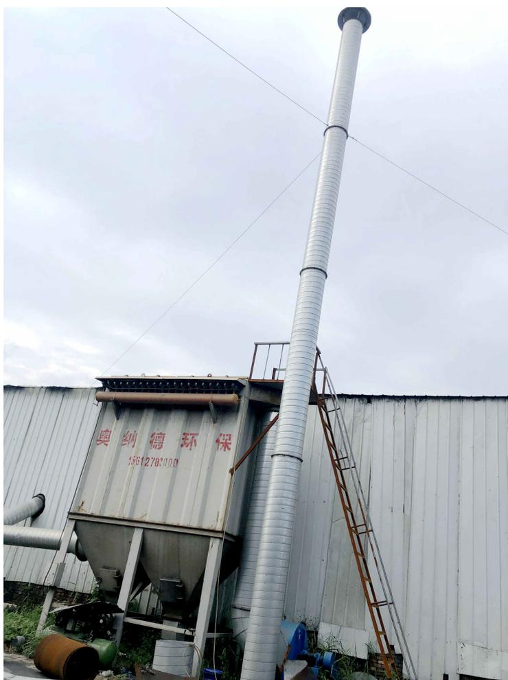
图 3-1 原料破碎、对辊工序除尘器和排气筒
