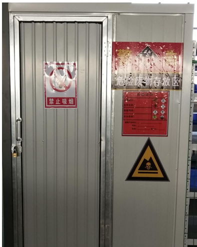
图 4-8 危废暂存间外部
