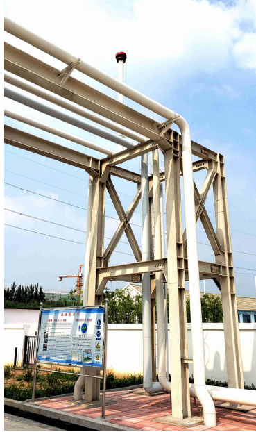
图 3-2 密闭油气回收鹤管
