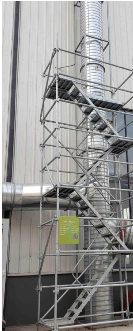
图 3-4 35m 高排气筒 (DA001) 和采样平台
