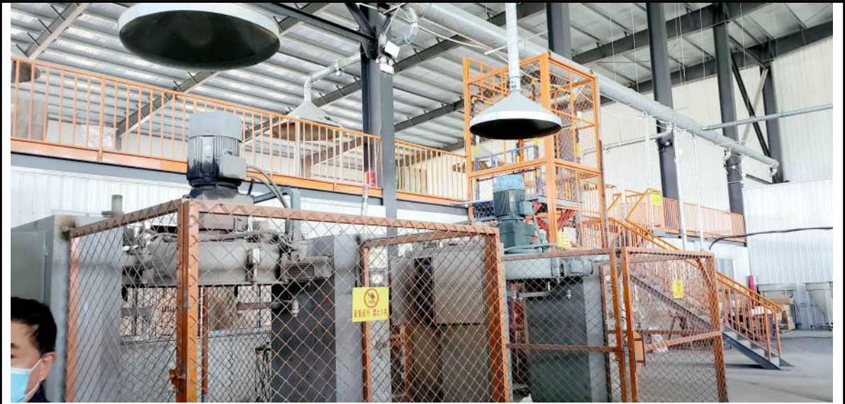
图 3-2 混合工序集气罩
