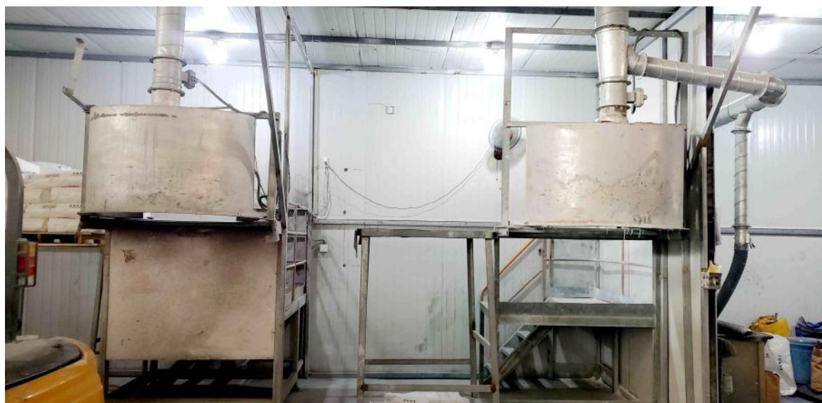
图 3-1 配料工序集气罩
