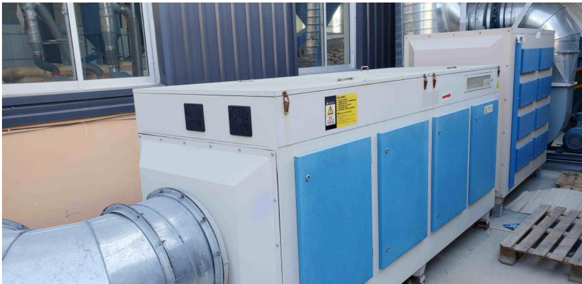
图 3-7 挤出废气处理活性炭吸附装置
