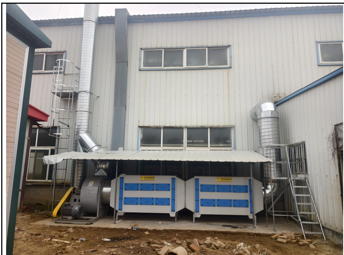
图3 检测孔和采样平台
